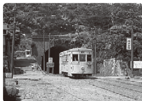
市電が通っていた頃の山手隧道
