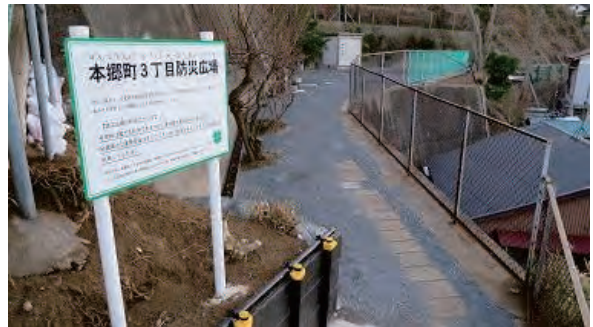
老朽空家の除去後に整備された「本郷町3丁目防災広場」
