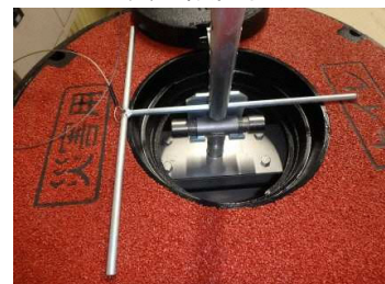
治具の設置状況
