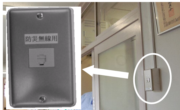
発災直後はローゼットにモジュラーケーブルを差し込んで電話をします。(職員室前廊下)
