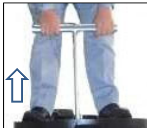
貯留弁引き上げ状況
