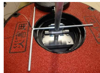
治具の設置状況
