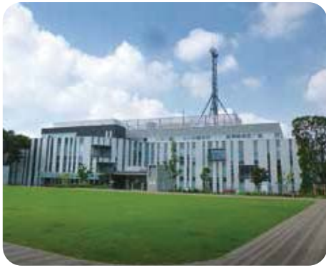
現在の瀬谷区総合庁舎
