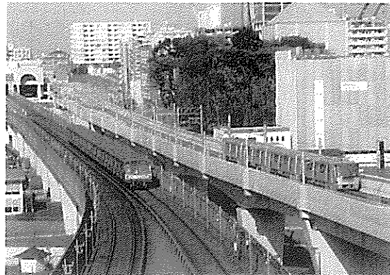
センター南～センター北間 走行試験
