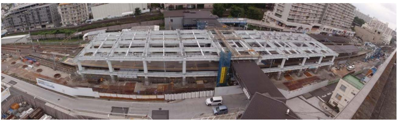
写真-① 星川駅鉄骨架設状況 (全体) (南側から北側を望む)
