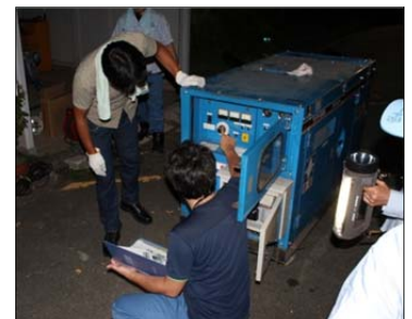
夜間発災対応実働訓練（西谷配水池）
