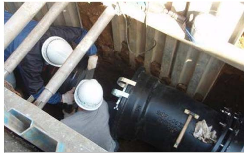
耐震管への布設替え工事
