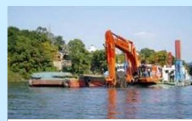
相模湖での土砂除去作業
