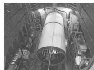
(仮称)新磯子幹線口径 1200mm送水管新設工事
