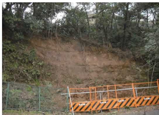
安全対策が必要な斜面地
