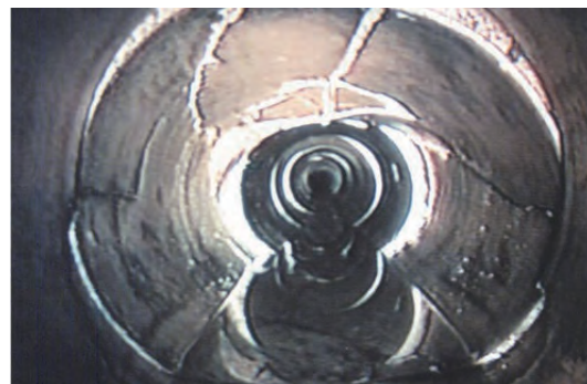
下水道管内の状態を点検・調査
