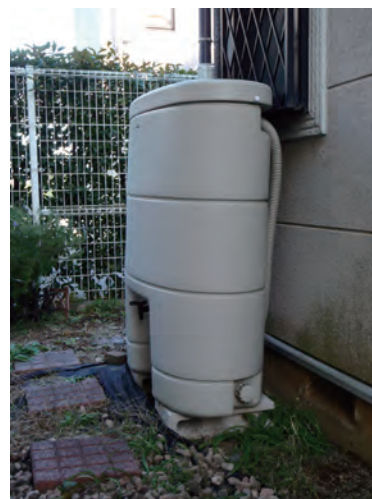
雨水貯留タンクの設置
