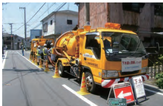
吸引車による下水道管の清掃
