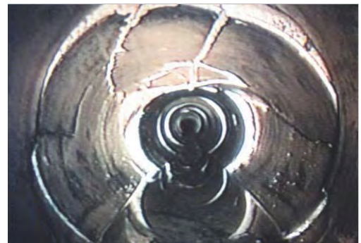
下水道管内の状態を点検・調査
