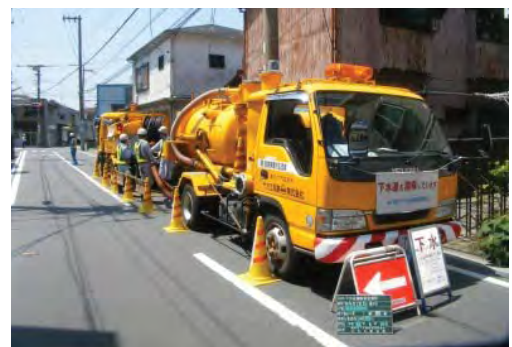
吸引車による下水道管の清掃
