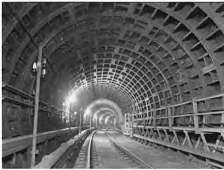
【平沼町シールドトンネル】
