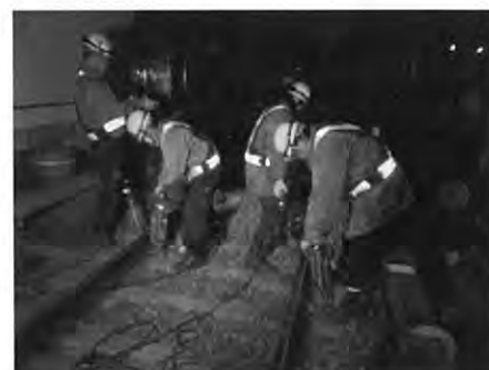
【軌道整備を行う地下鉄保守職員】
