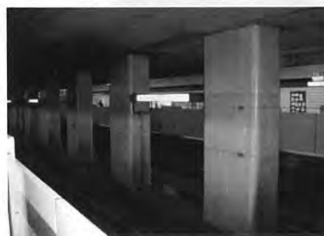
【中柱を補強した開削トンネル】
