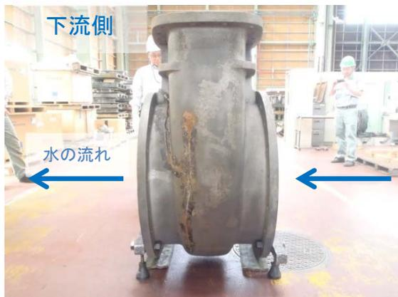
写真 3 バルブのひび割れの状況
