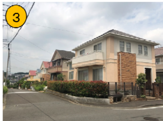
地区内の戸建住宅
