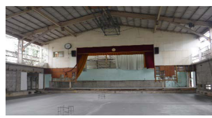
小学校体育館の改修工事
