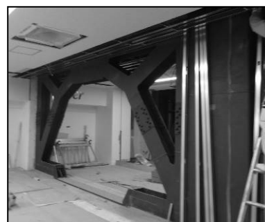
耐震改修事例（ブレース設置工事） （株）ケー・アール建築研究所 提供
