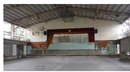
小学校体育館の改修工事
