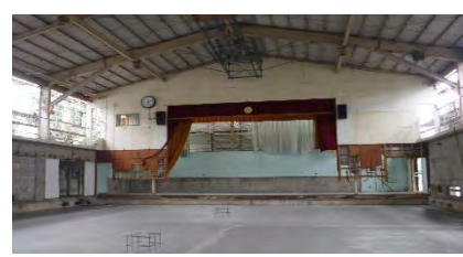
小学校体育館の改修工事
