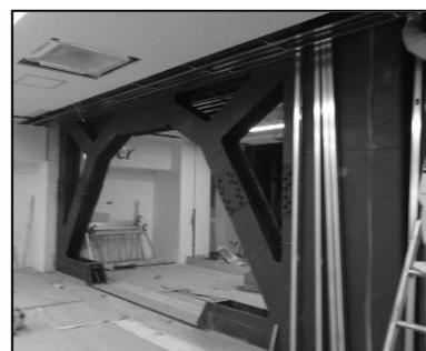
耐震改修事例（ブレース設置工事）
