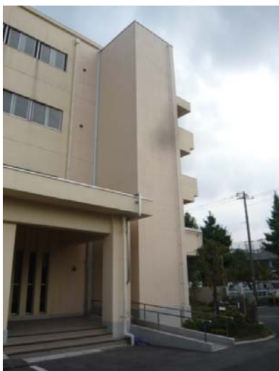
エレベータ及びスロープの設置
