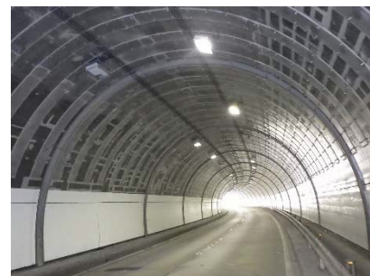
トンネル長寿命化工事後の状況
