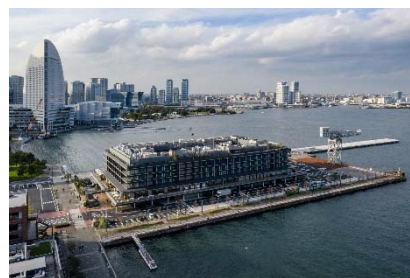
新港ふ頭客船ターミナル
