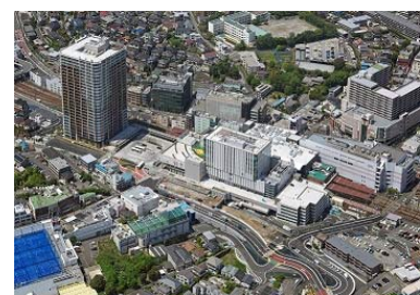
二俣川駅南口地区市街地再開発事業
