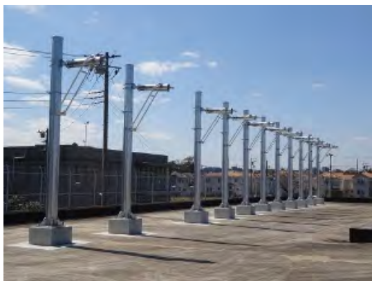
<留置線引留柱工事>
