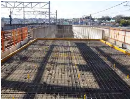
<駅ホーム工事>
