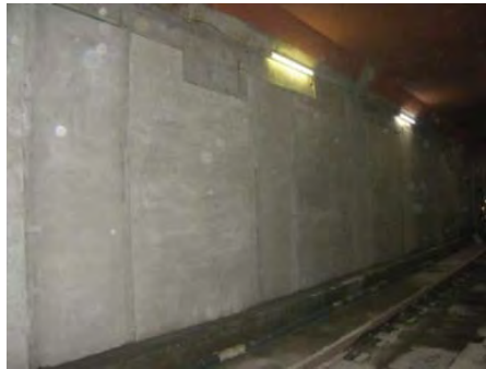
<関内駅構築補修>
