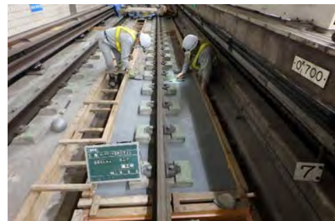
<軌道改良工事>
