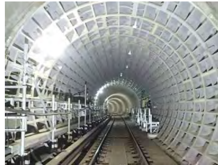
<シーールドトンネルの補修>
