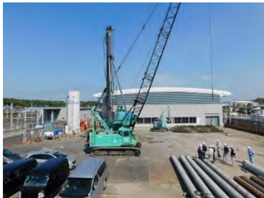
<検修庫増築工事>
