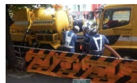
下水道管清掃状況
