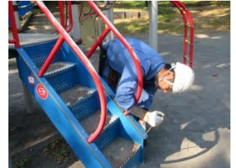
遊具点検の例
