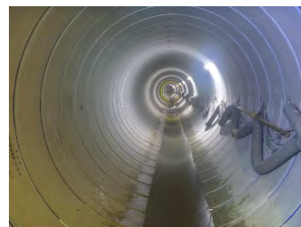
雨水幹線整備状況(推進工法)
