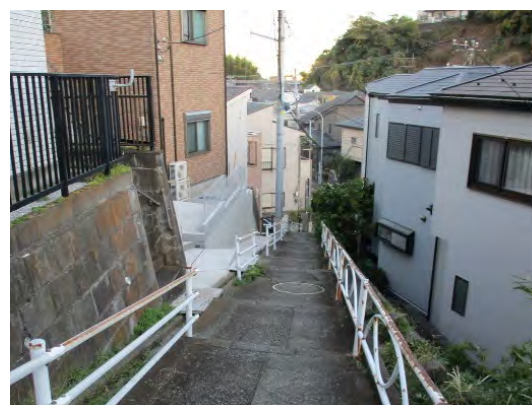
写真 階段に沿って密集した建物
