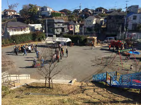
写真 防火水槽や防災備蓄倉庫を設置している本郷町ガス山公園（中区）
