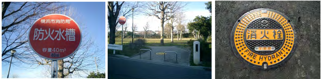
写真 消防水利の例
