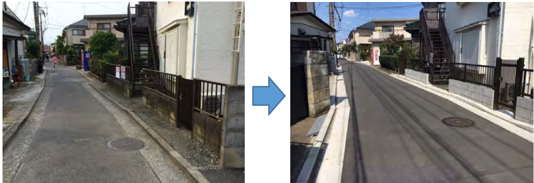
写真 狭あい道路の拡幅整備
