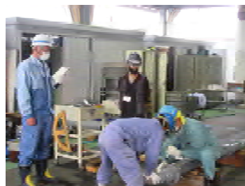
日本水道協会 配水管工技能講習会の様子
