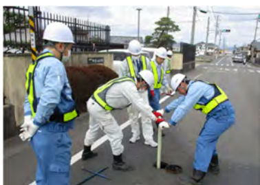
水道局、横浜ウォーターとの連携 による支援の様子
