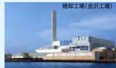
焼却工場(金沢工場)
