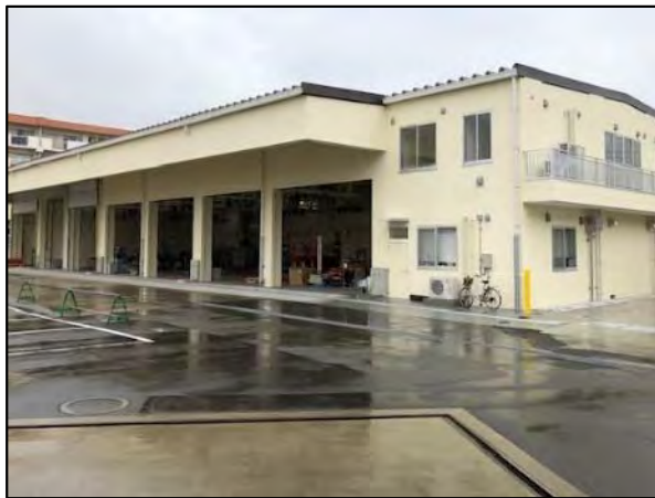
滝頭新工場（研修施設併設）
