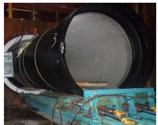
大口径管路更新工事
