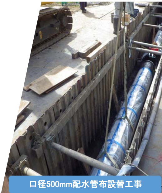
口径700mm配水管布設替工事
