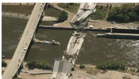
写真1 橋梁崩落事故の状況
