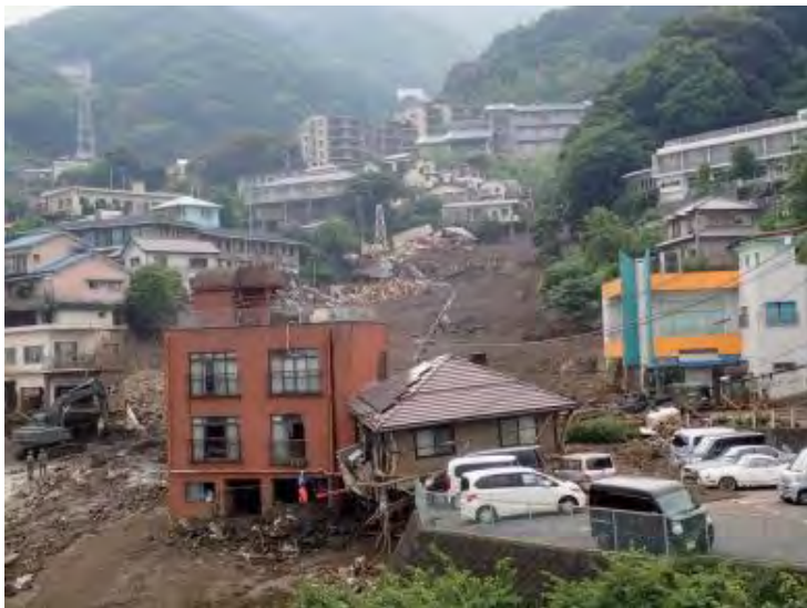
令和3年 熱海市の土石流被害 内閣府 令和4年版防災白書から抜粋
