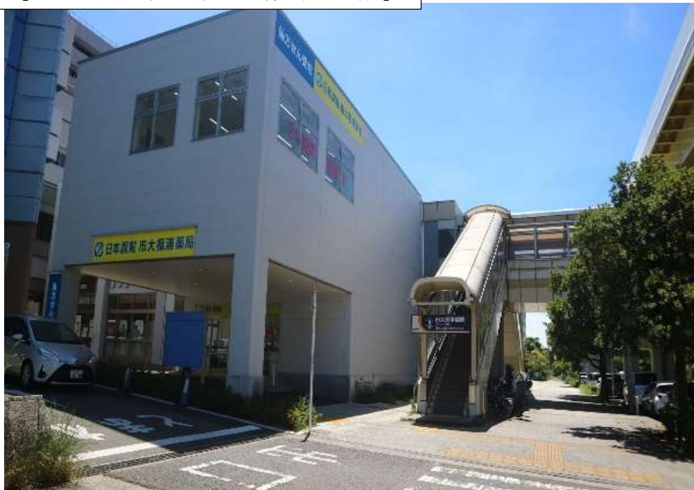
【公道側から見た敷地内薬局の全景】
