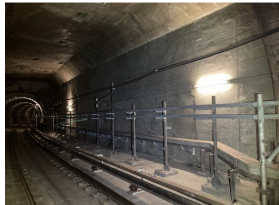
<開削トンネルの補修>
