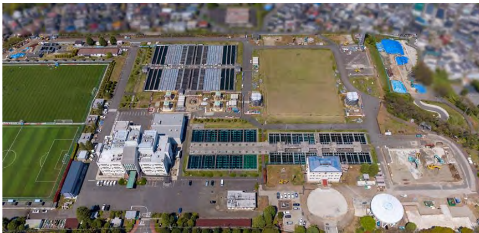
西谷浄水場（再整備事業前）
