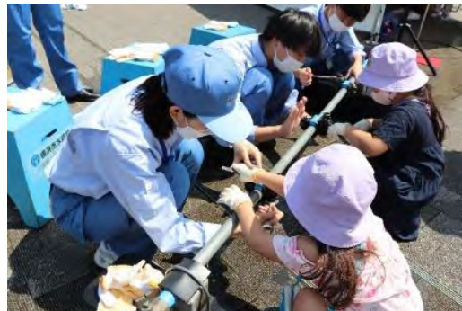
イベントでの漏水修理体験
