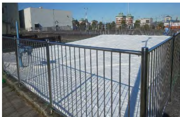
建築用養生シート設置後の様子
