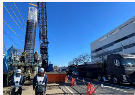
橋りょう基礎杭の施工状況
