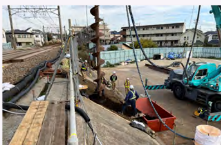
土留杭の施工状況
