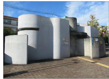
青葉台駅前公衆トイレ
