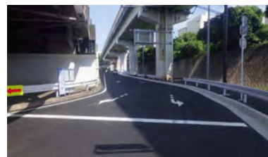
上川井IC出口(横浜町田方面からのオフランプ)の拡幅
