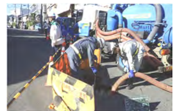
下水道管清掃状況
