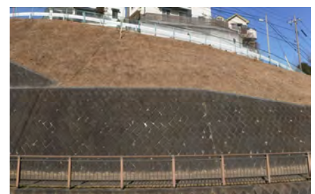
緑区梅田川 対策工事実施予定箇所
