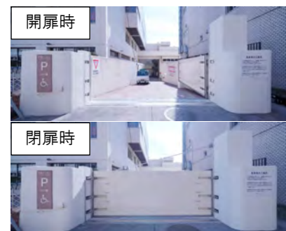
大型スイング式止水扉 (戸塚ポンプ場)
