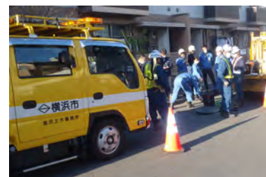
土木事務所作業状況
