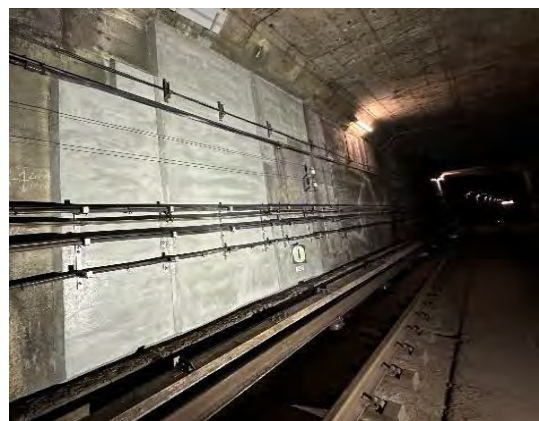
＜開削トンネルの補修＞
