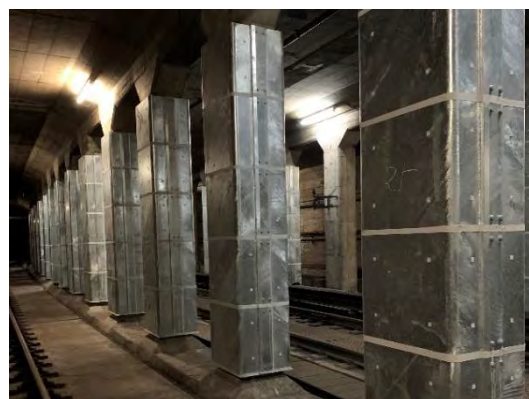
<開削トンネル部>
