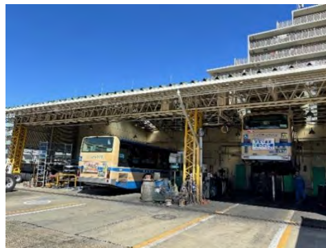
<緑営業所車両整備工場>
