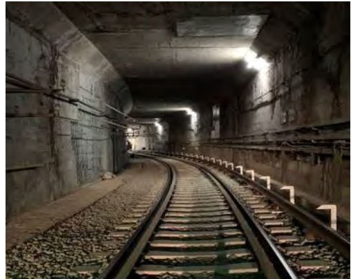
&lt;急曲線軌道改良工事施工後&gt;
