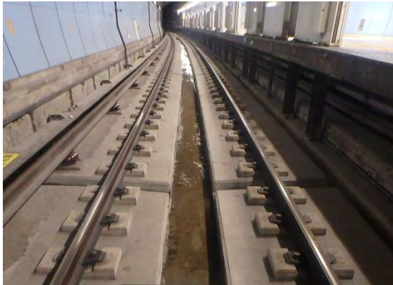
&lt;軌道改良工事施工後&gt;
