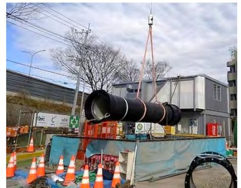
口径800mm配水管布設替工事
