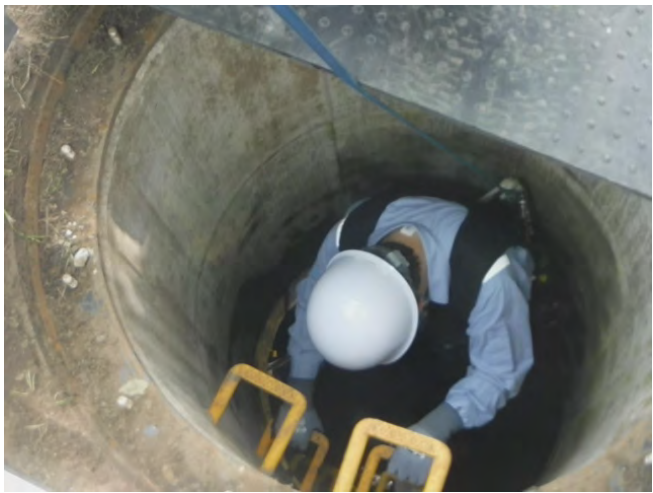
写真－７ マンホールから 管きょ内へ降りる状況（２）
