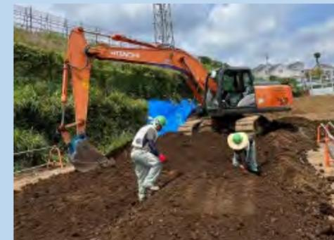
写真 3 レンガ片の除去 (手作業)
