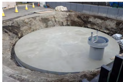
< 防火水槽新設工事 >
