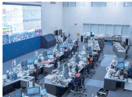
<消防司令センター>
