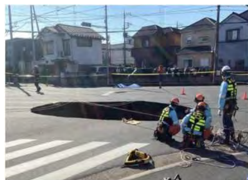
写真：道路陥没の事例
