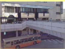
ペDESTリアンデッキとラビス3の接続部は階段のみ
