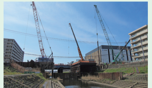
▲高島橋の架け替え工事 (2023年3月撮影)
