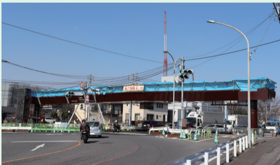
▲不動坂交差点歩道橋の工事 (2023年3月撮影)
