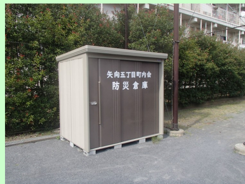
設置許可のうえ、設置した防災倉庫
