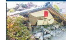
◀屋根が落ち全壊した家屋(熊本市内)
